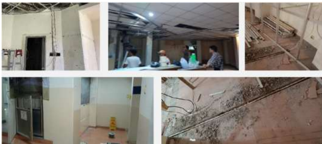
Gambar 8. Proses pembobokan dan pemasangan titik lampu pada area Lobby Sekolah Pilar Indonesia
