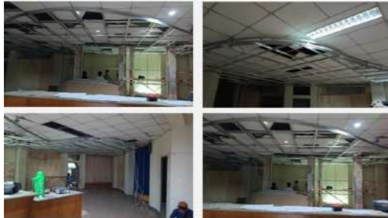
Gambar 7. Pemasangan rangka plafon pada area Lobby Sekolah Pilar Indonesia
