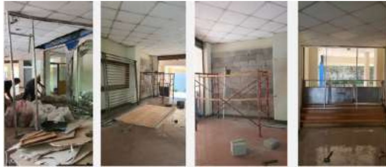
Gambar 5. Pembobokan dan pemasangan dinding bangunan Lobby Sekolah Pilar Indonesia
