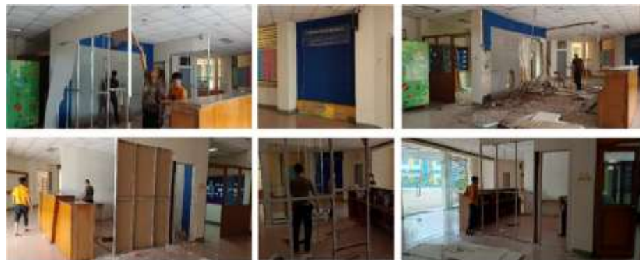
Gambar 4. Pembobokan dan pembongkaran existing bangunan Lobby Sekolah Pilar Indonesia
