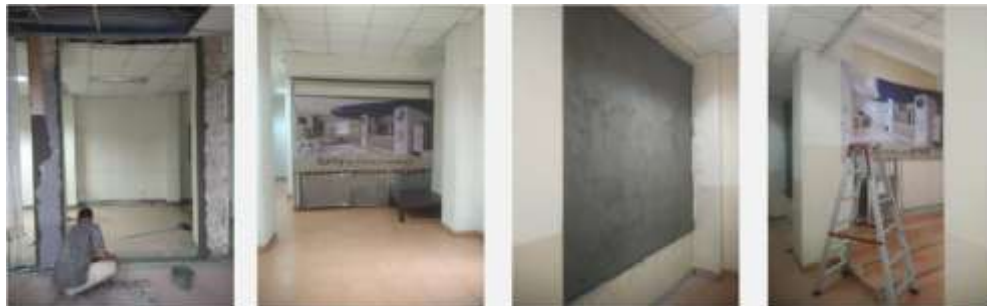
Gambar 6. Plester dinding pada area Lobby Sekolah Pilar Indonesia
