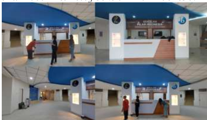
Gambar 11. Proses finishing dan pengecekan meja lobby, plafon, elektrik dan lantai pada area Lobby Sekolah Pilar Indonesia
